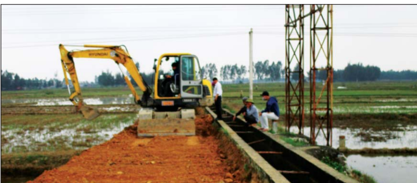
Yên Thành xây dựng 500 đường giao thông và kênh mương bê tông nội đồng, tạo nguồn nước tưới thâm canh 13 ngàn ha lúa vụ xuân
