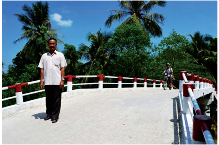
Một cây cầu từ thiện do ông và các thành viên thi công
