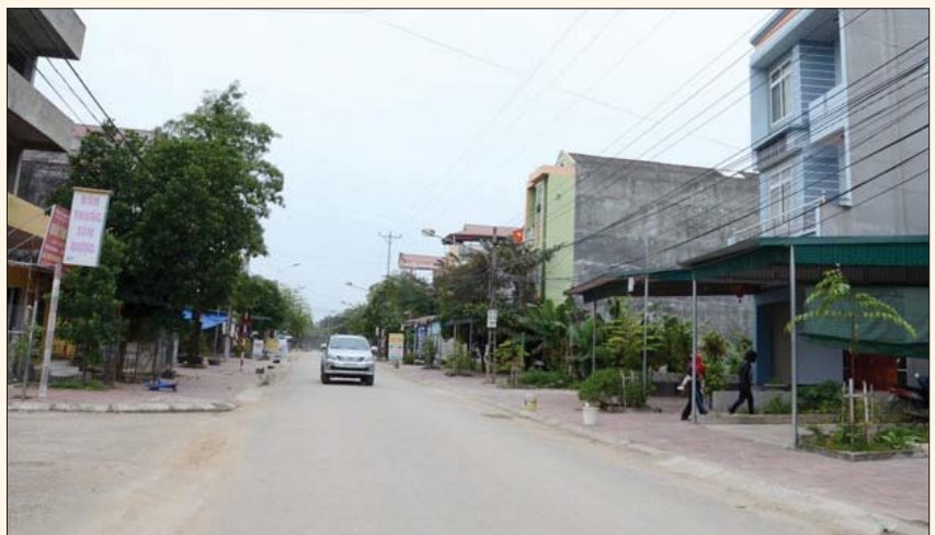
Một góc khu dân cư tổ 6, phường Nông Tiến (TP Tuyên Quang) có hệ thống cống thoát nước đảm bảo.
